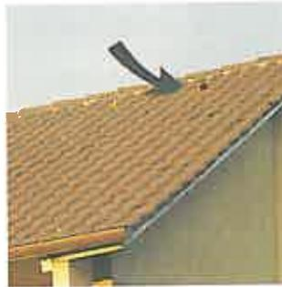
3. Lüftungsziegel als Einflugmöglichkeit, jedoch nur auf einer Seite des Hauses, um Durchzug zu vermeiden (Sieb heraustrennen). Unterspannfolie an diesen
